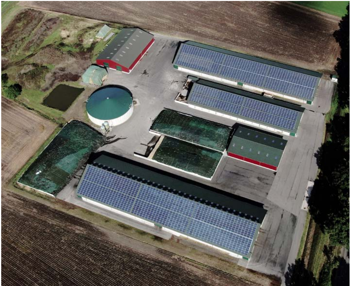
SUNFarm mit einer Leistung von 669,76 kWp und 2392 Modulen
