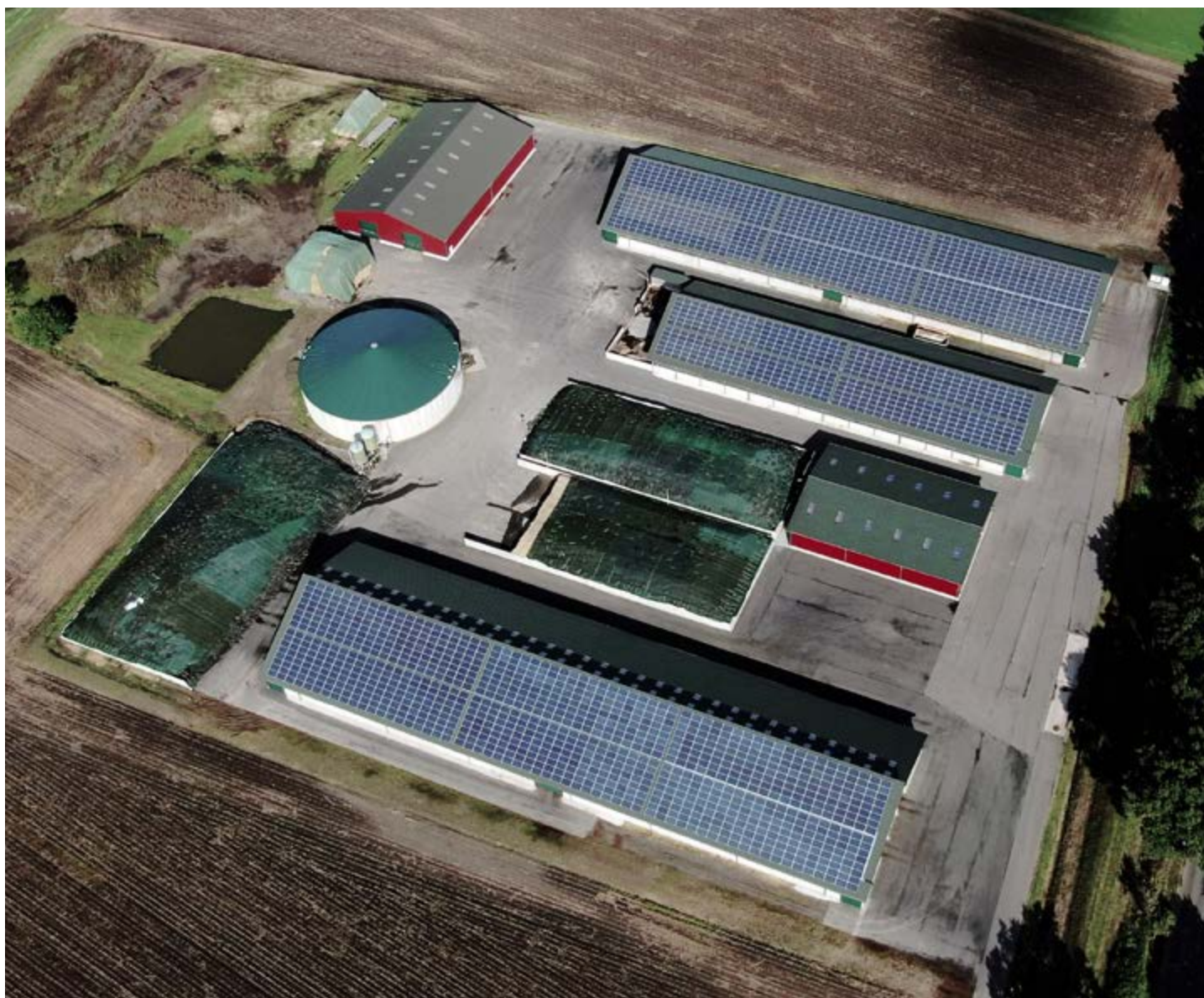
SUNFarm o wydajności 669,76 kWp z 2393 modułami
