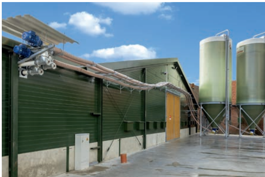
System FlexVeyPUR umożliwia nawet 100%-wy transport paszy z silosu do budynku
