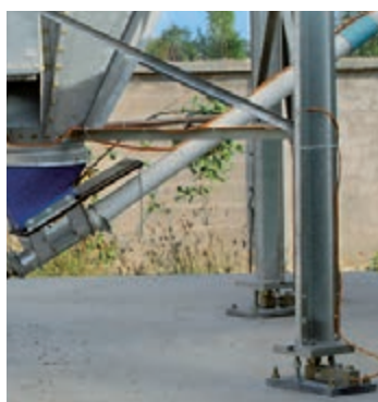
Wagi pod silos
