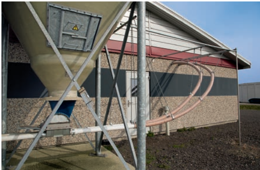
Zastosowanie FlexVey PUR w połączeniu ze sztywną rurą FlexVey
